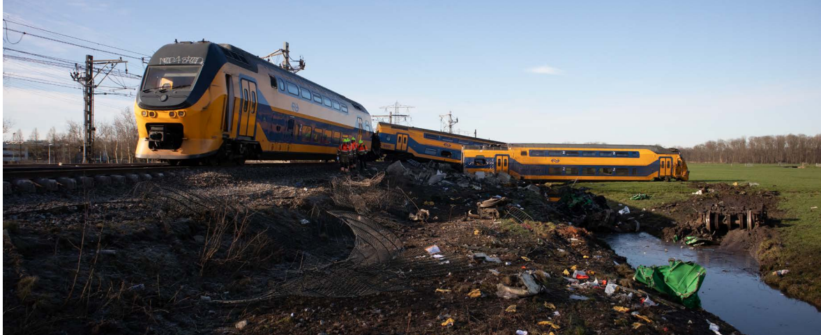
▲ Figuur 19: Beeld van ontspoorde reizigerstrein (van links naar rechts zichtbaar, de achterste/vierde rijtuigbak, de tweede rijtuigbak en de voorste rijtuigbak).
