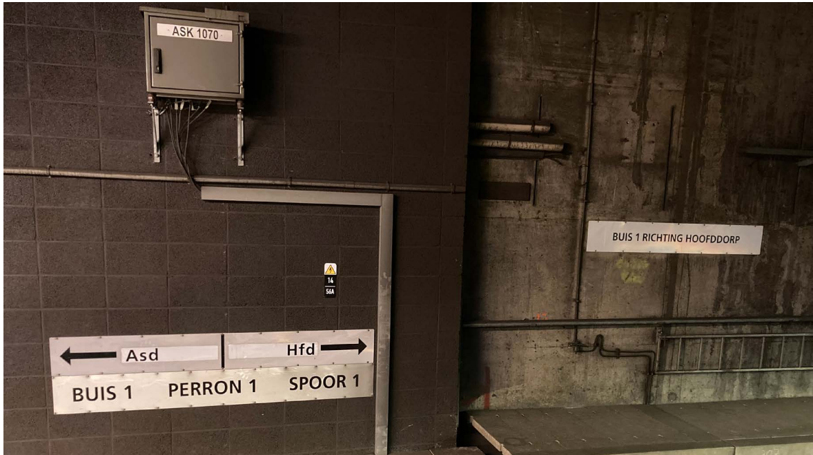
▲ Figuur 71: Oriëntatieborden in de Schipholtunnel (Asd, Amsterdam en Hfd, Hoofddorp).
