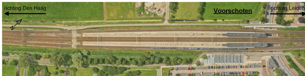
▲ Figuur 34: Luchtfoto van station Voorschoten, met links van het station een railinzetplaats, rechts op het perron de twee overkappingen en aan de rechterzijde het viaduct van de Wijngaardenlaan dat onder het spoor doorgaat (bron: ProRail).
