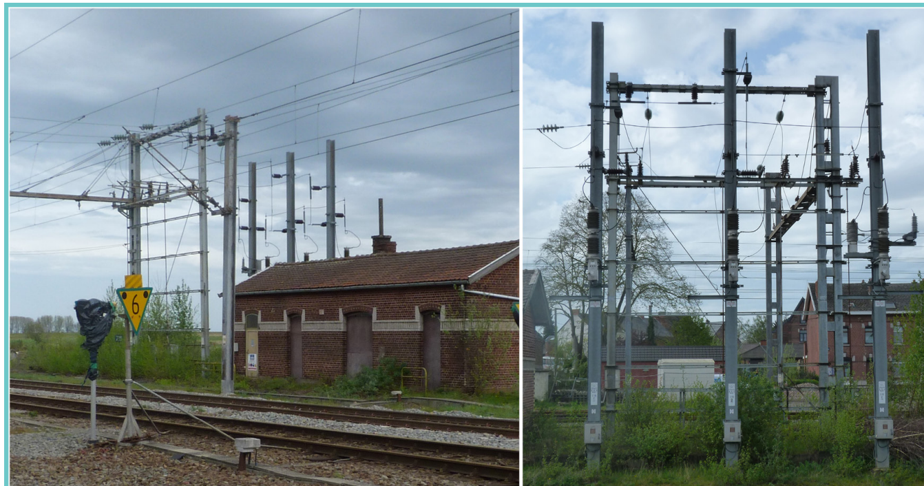
Aperçu de la herse (photo de gauche : depuis les voies, photo de droite à l'arrière de la herse)
