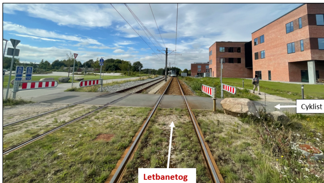
Figur 1. Ulykkessted ved overgang med forskydningsbomme. Kilde: AAL, med påtegninger af Havarikommissionen.
