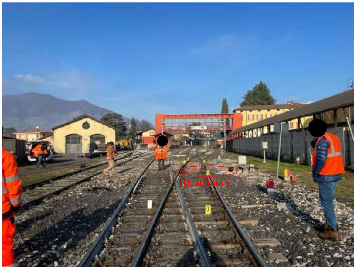
Figura 15 – Localizzazione del deviatolo 5 (fonte immagine: Ufficio; elaborazione: Ufficio).
