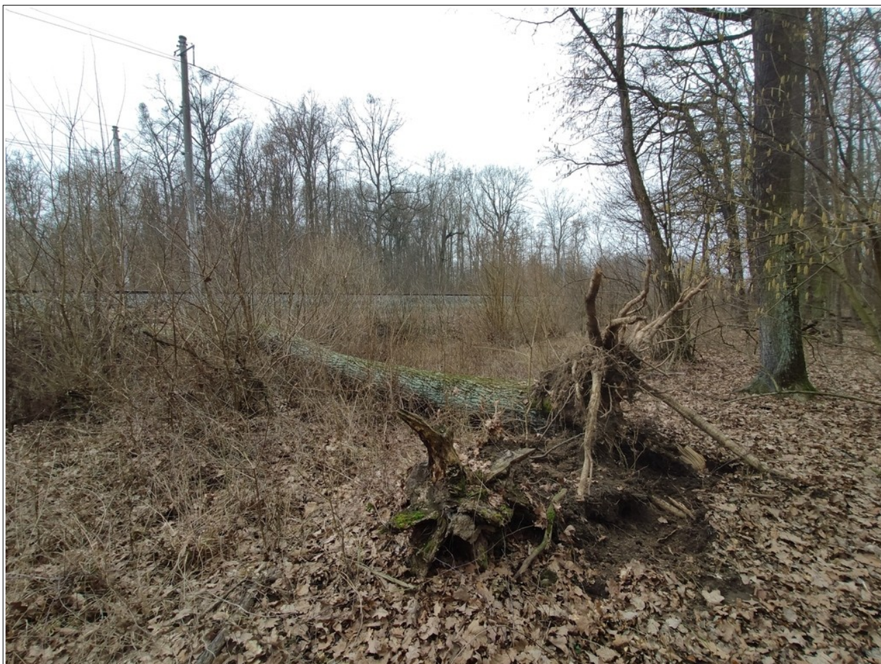
Obr. č. 8: Pohled na kořenový bal a část kmene stromu rostoucího na pozemku p. č. 1029 vyvráceného v km 69,426 přes obě TK mezistaničního úseku Štěpánov – Červenka
