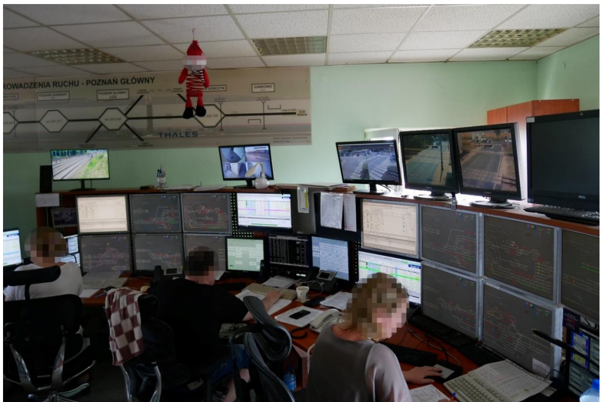
Zdjęcie 6 - Stanowiska dyżurnych ruchu C i D oraz dyżurnego ruchu dysponującego
