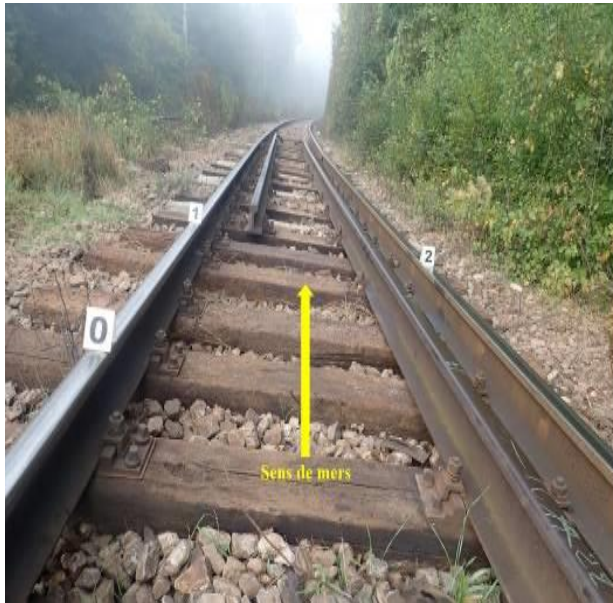
Foto nr.9 – Curbă cu deviația dreapta
