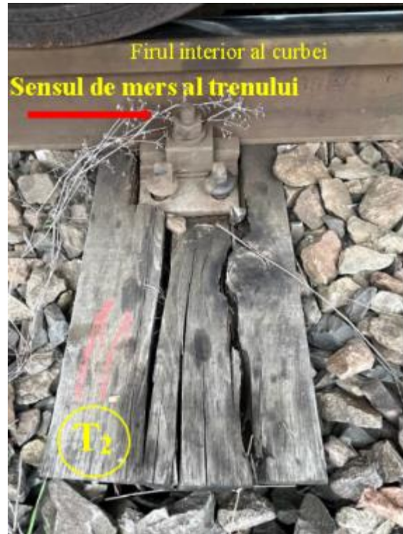
Foto nr.20 - Capătul traversei T_2 pe firul interior
