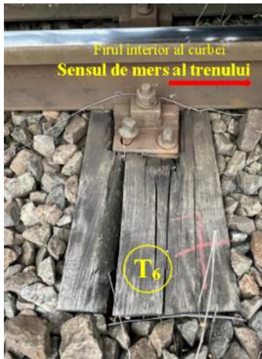
Foto nr.27 - Capătul traversei T 6 pe firul exterior Foto nr.28 - Capătul traversei T 6 pe firul interior
