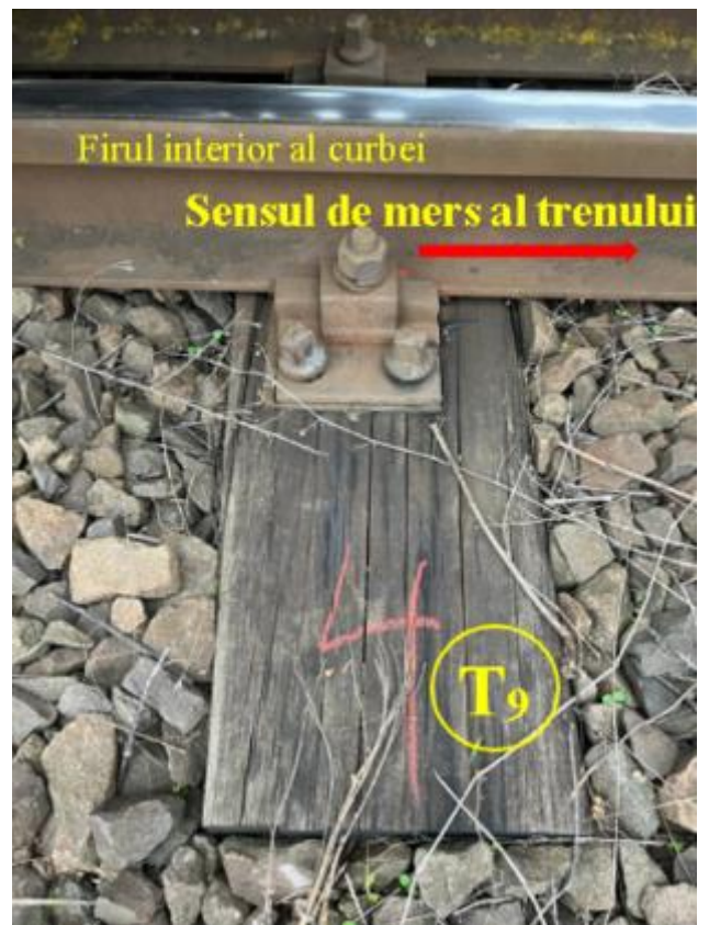
Foto nr.34 - Capătul traversei T 9 pe firul interior
