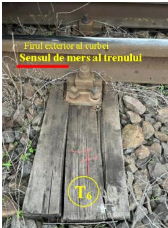
Foto nr.27 - Capătul traversei T 6 pe firul exterior Foto nr.28 - Capătul traversei T 6 pe firul interior
