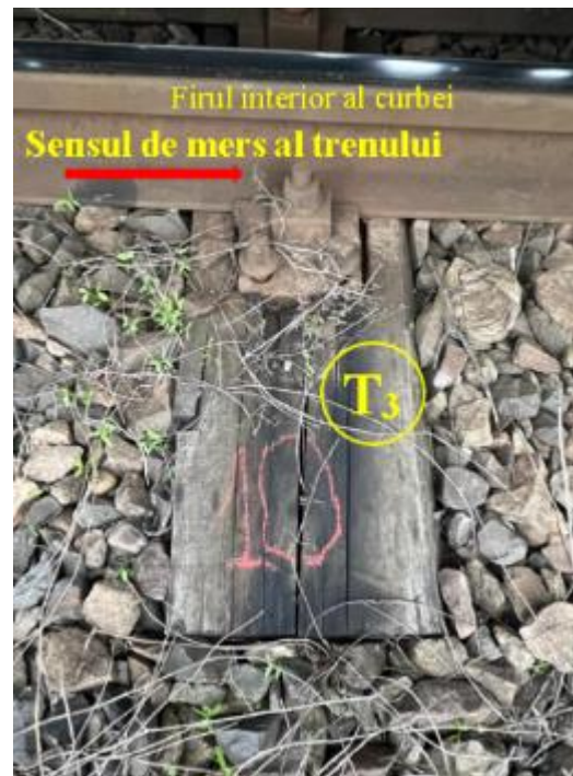
Foto nr.22 - Capătul traversei T_3 pe firul interior
