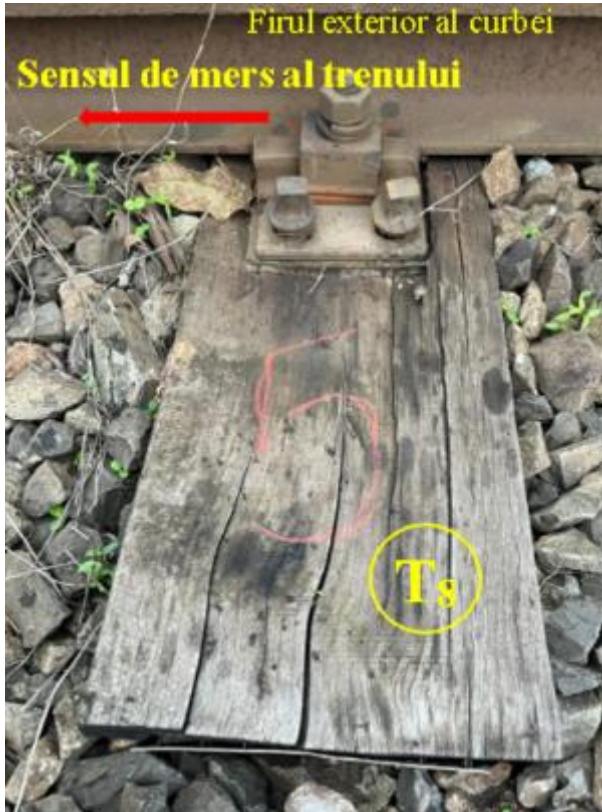
Foto nr.31 - Capătul traversei T 8 pe firul exterior
