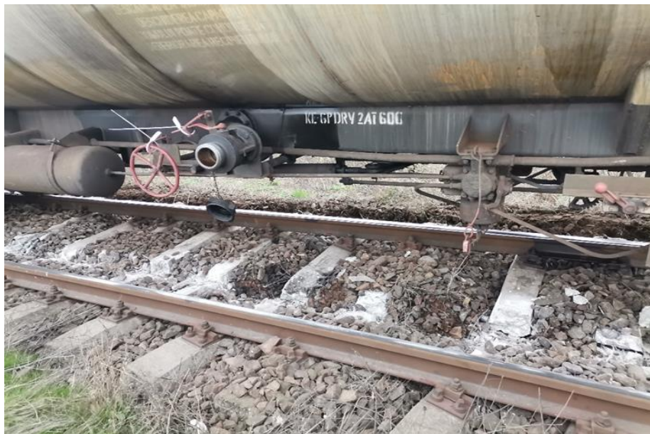
Foto nr.8 – Traverse din beton răsucite și rupte
