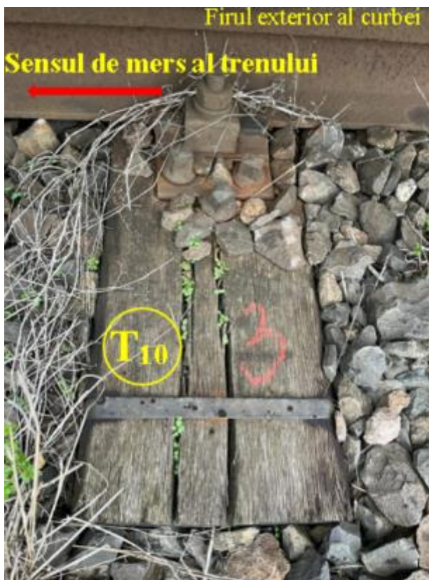
Foto nr.35 - Capătul traversei T 10 pe firul exterior
