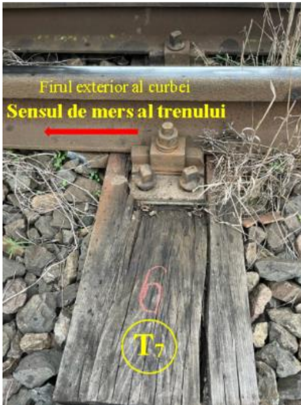
Foto nr.29 - Capătul traversei T 7 pe firul exterior
