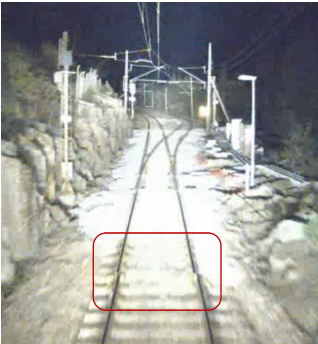
Figur 3: Skjermdump fra video fra frontkameraet i tog 251 (rød markering viser stedet for avsporingen). Foto: Vy Gjøvikbanen AS
