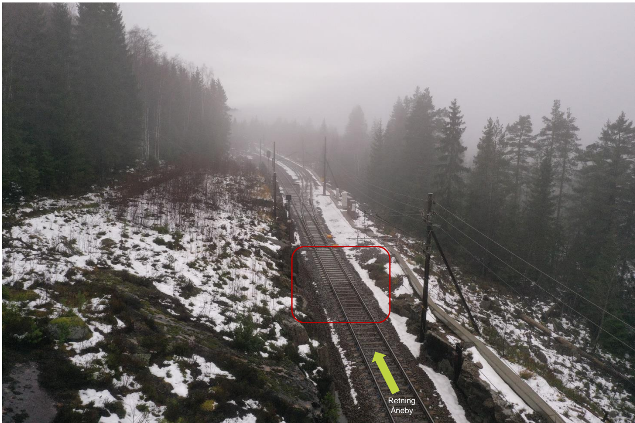
Figur 2: Stedet der avsporingen skjedde, retning nord. (rød markering viser sted for avsporing). Foto: SHK
