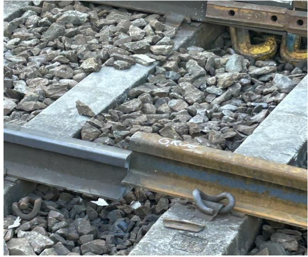
Figur 8: Skinneskjøten før montering av midlertidige lasker. Foto: Bane NOR SF
