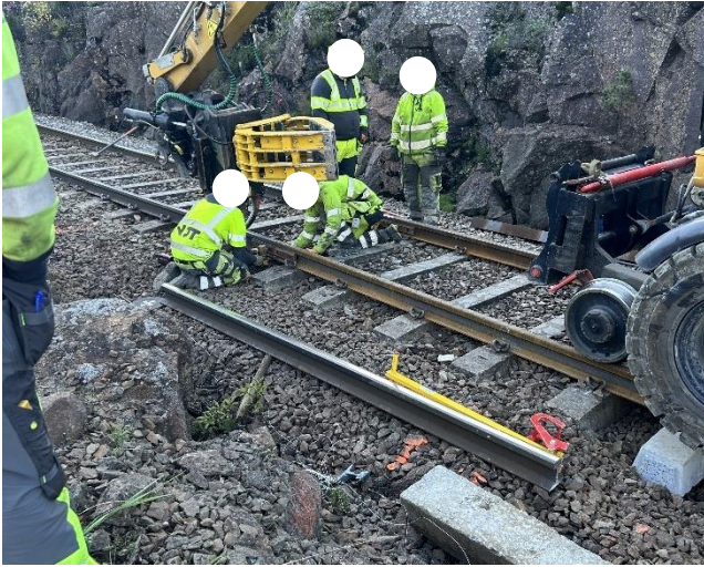
Figur 7: Montering av midlertidige lasker ved Åneby stasjon. Foto: Bane NOR SF
