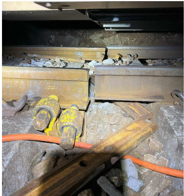
Figur 4: Avsporingssstedet, etter at avsporingen har funnet sted. Foto: Bane NOR SF
