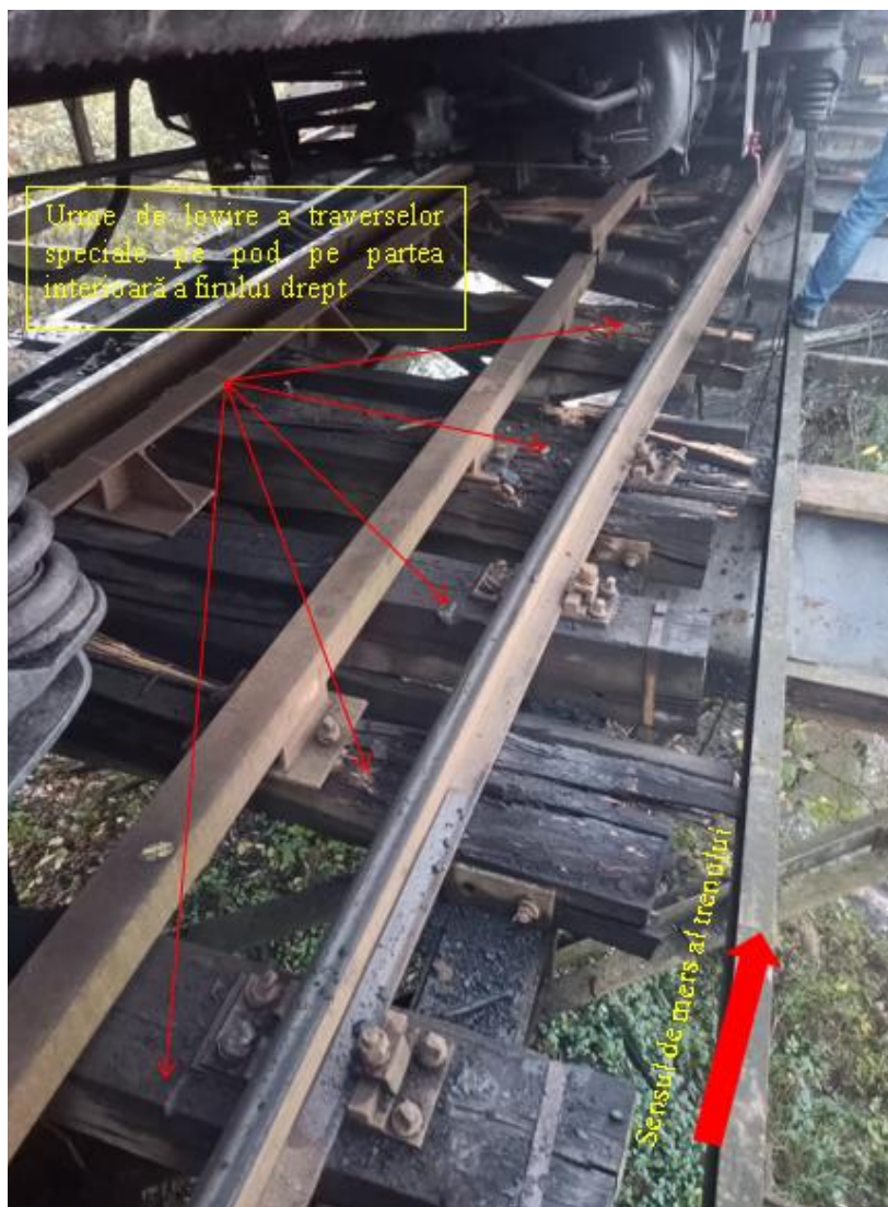
Foto nr.14: Urme de lovire a traverselor speciale de lemn pe pod
