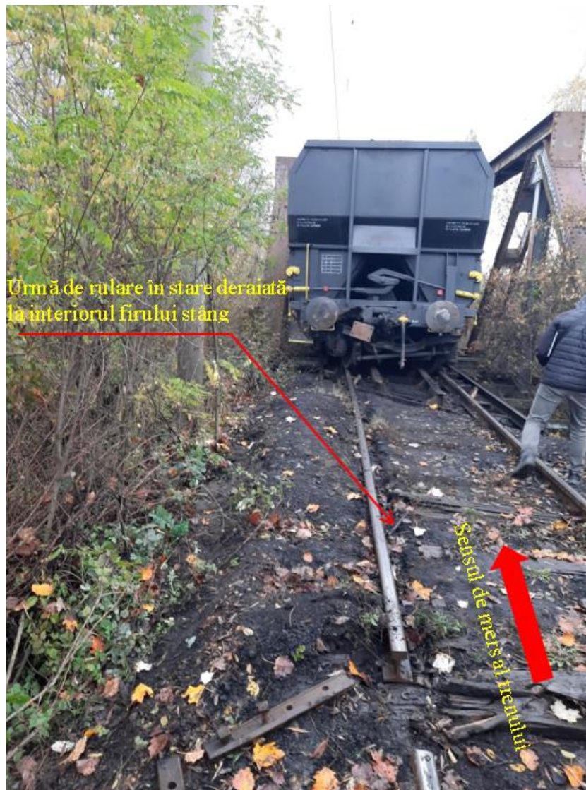
Foto nr.13: Urmă de rulare în stare deraiată pe terasament la interiorul firului stâng
