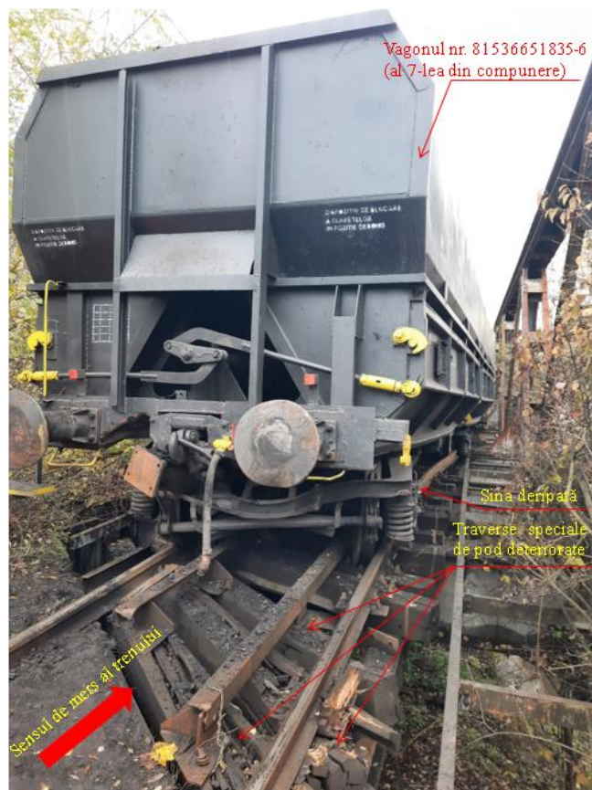
Foto nr.15: Starea traverselor pe pod în urma deraierii
