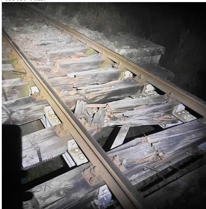
Foto nr. 7 – Traversele podețul feroviar de la km76+580
